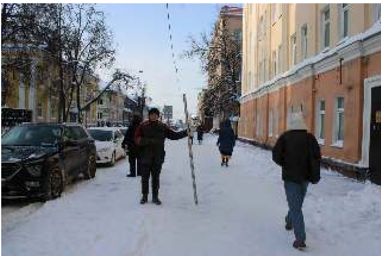
Илл. 30. Общий вид земельных участков, отведенных для расположения объекта: «Теплотрасса отопления от вывода из д. 4 по ул. Маслякова до точки в 7 м от ТК-7 у д. 16 по ул. Маслякова в направлении ТК-8 у д. 9 по ул. Маслякова, до точки в 5 м от ТК-4 у д. 14 по ул. Маслякова в направлении ТК-4-1 у д. 14а по ул. Маслякова, до д. 9, 14, 16/102 по ул. Маслякова; сети ГВС от вывода из д. 4 по ул. Маслякова до д. 3а по ул. Маслякова». Точка фотофиксации 4. Вид с востока.
