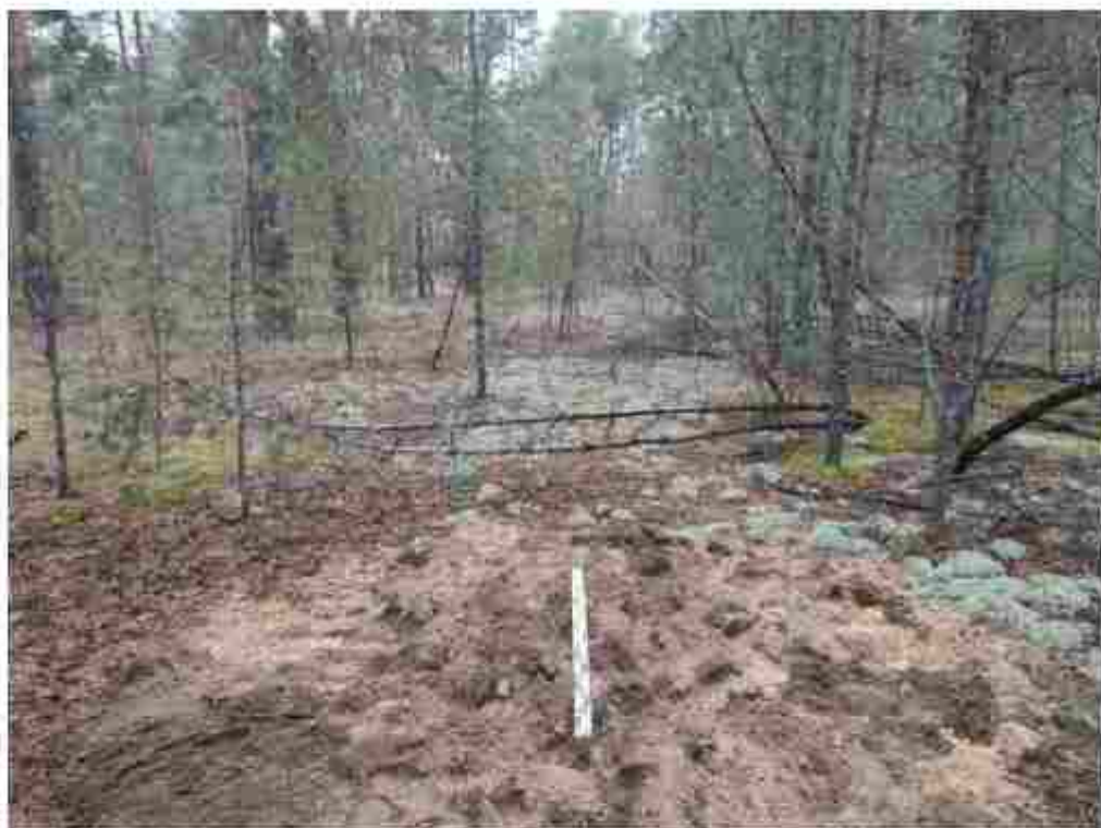
Илл. 472. Объект «Шифр объекта - М-41/25-21, Нижегородская область, Володарский район, вблизи п. Мулино». Шурф № 103. Рекультивация. Вид с Ю.
