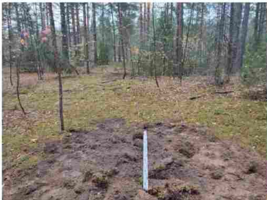
Илл. 436. Объект «Шифр объекта - М-41/25-21, Нижегородская область, Володарский район, вблизи п. Мулино». Шурф № 94. Рекультивация. Вид с Ю.
