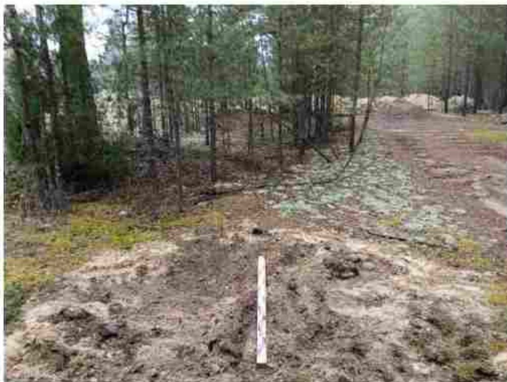
Илл. 396. Объект «Шифр объекта - М-41/25-21, Нижегородская область, Володарский район, вблизи п. Мулино». Шурф № 84. Рекультивация. Вид с Ю.
