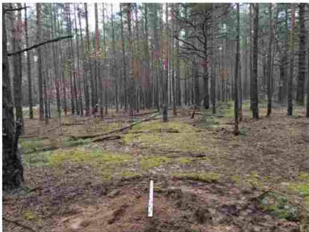
Илл. 360. Объект «Шифр объекта - М-41/25-21, Нижегородская область, Володарский район, вблизи п. Мулино». Шурф № 75. Рекультивация. Вид с Ю.
