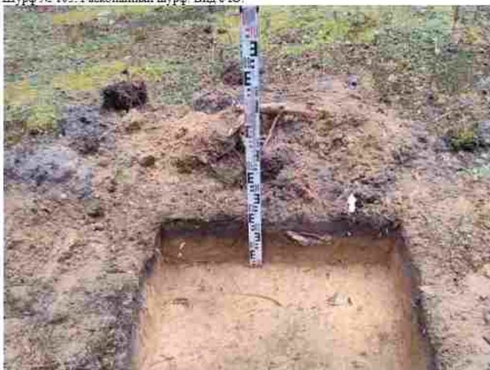
Илл. 479. Объект «Шифр объекта - М-41/25-21, Нижегородская область, Володарский район, вблизи п. Мулино». Шурф № 105. Северная стенка и дно. Вид с Ю.
