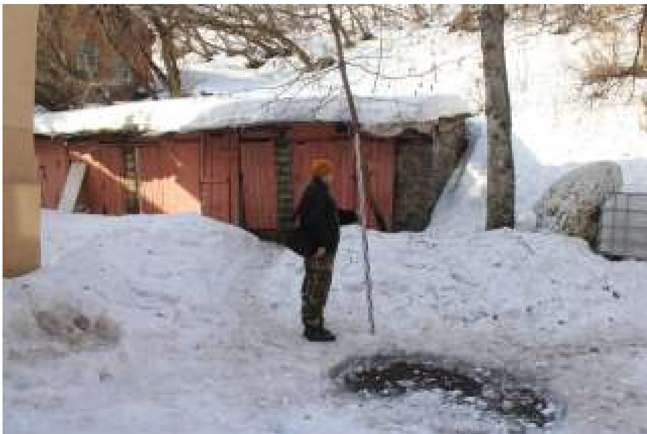
Илл. 27. Общий вид земельных участков, отведенных для расположения объекта: «Газопровод давлением до 0,005 МПа от точки присоединения к распределительному газопроводу до объекта по адресу: г. Нижний Новгород, ул. Почаинская, д. 13а, пом.П1» (код объекта: 527 ОКС-Л). Точка фотофиксации 2. Вид с севера.
