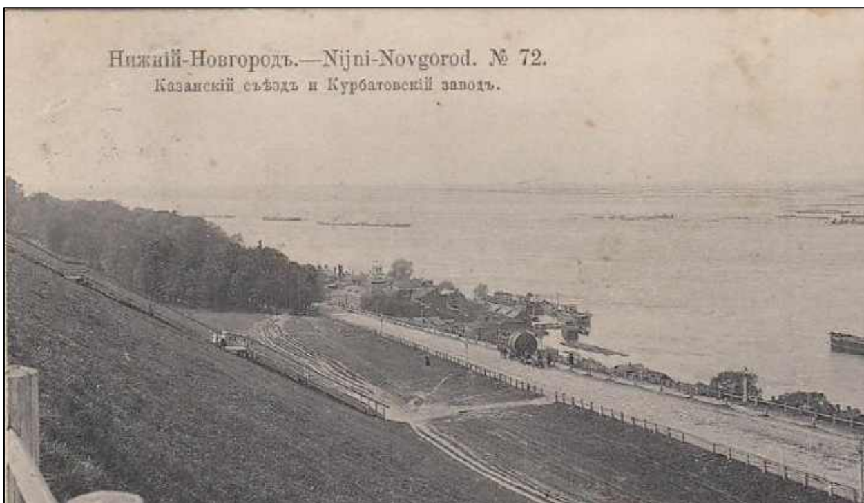
19. Общий вид Казанского съезда и Курбатовского завода. Из проекта предмета охраны Объекта (г. Нижний Новгород. ООО «Проектреставрация». 2020 г.). Архив УГО ОКН НО
