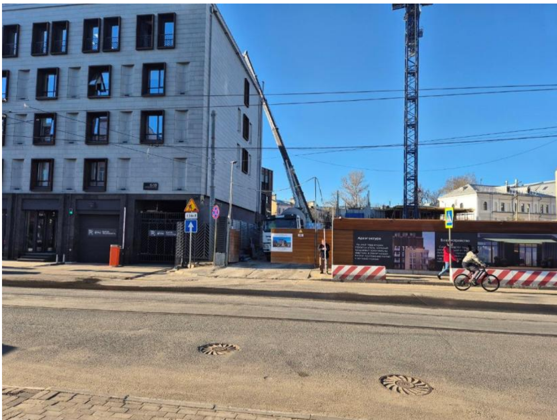
Рис. 34. Обеспечение сохранности ОКН федерального значения «Культурный слой города» в г. Нижний Новгород. 2026 г. Точка фотофиксации 1. Вид с Ю.
