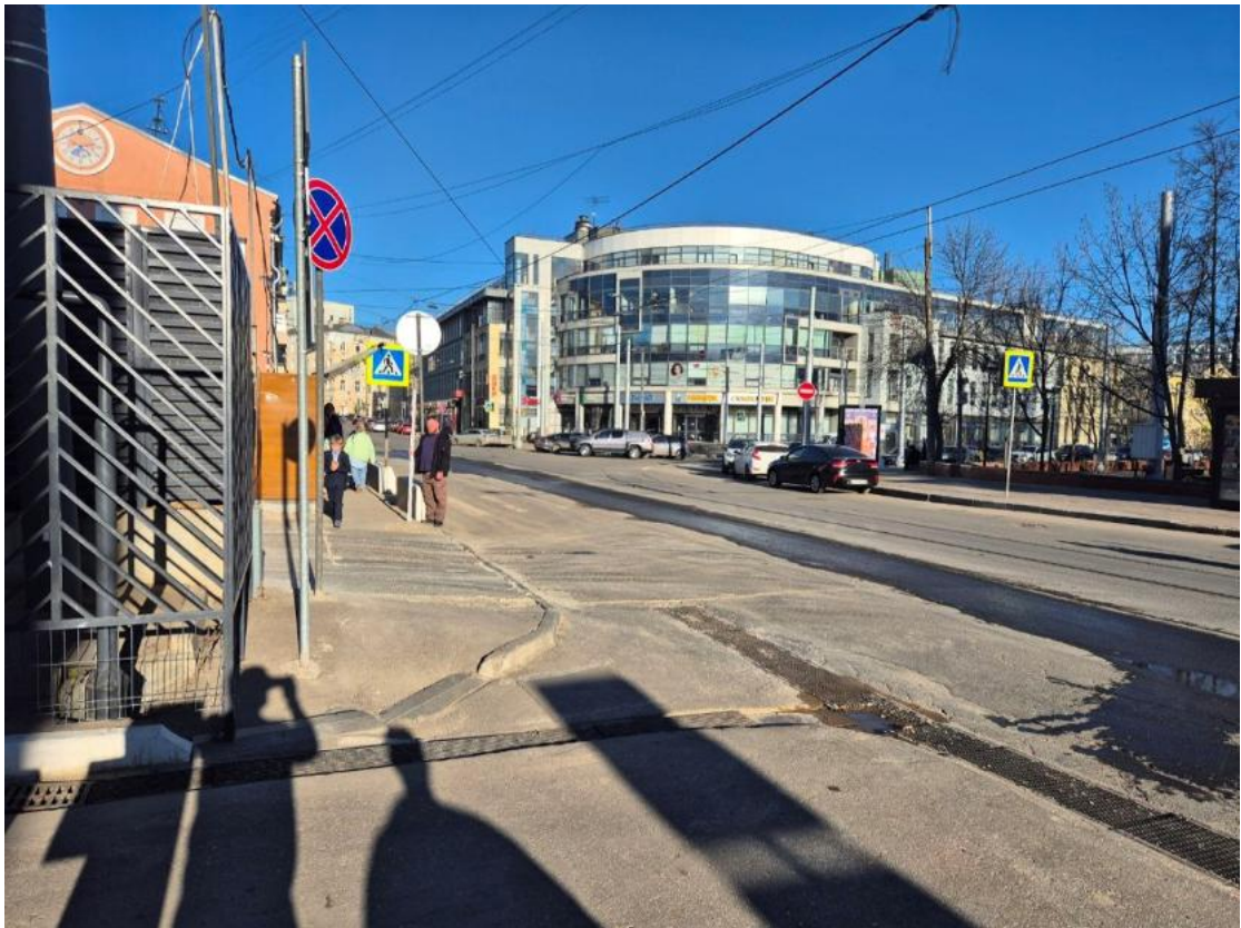
Рис. 36. Обеспечение сохранности ОКН федерального значения «Культурный слой города» в г. Нижний Новгород. 2026 г. Точка фотофиксации 3. Вид с 3.
