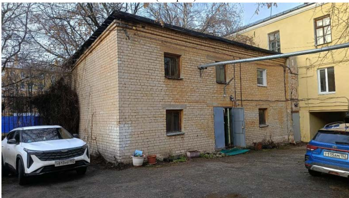
Фото 4. Предполагаемое к сносу здание по адресу: Нижегородская область, г. Нижний Новгород, Нижегородский район, Верхневолжская набережная, д. 21/22 (литера К)
