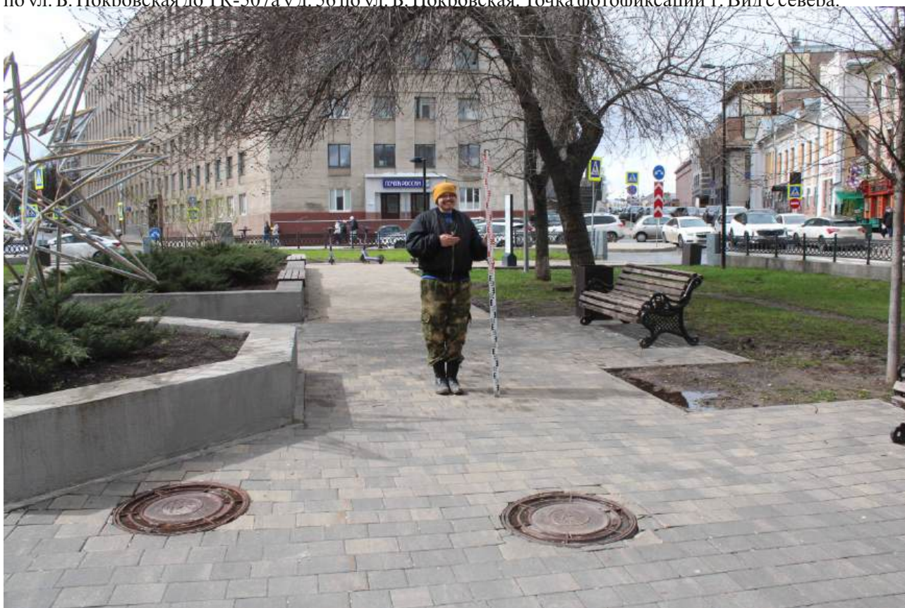
Илл. 25. Общий вид земельных участков, отведенных под расположение проектируемого объекта: «Сооружение-Магистральная теплотрасса отопления от кот. НТЦ, 5 очередь (ПАВ-9)» кад. № 52:18:0000000:13216 на участке: от т. в 48 м от ТК-506а у д. 56 по ул. Звездинка в сторону ТК-507 у д. 56 по ул. Б. Покровская до ТК-507а у д. 56 по ул. Б. Покровская. Точка фотофиксации 1. Вид с востока.
