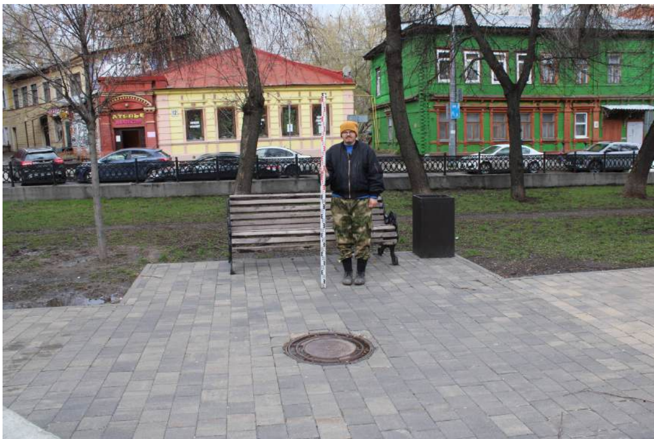
Илл. 22. Общий вид земельных участков, отведенных под расположение проектируемого объекта: «Сооружение-Магистральная теплотрасса отопления от кот. НТЦ, 5 очередь (ПАВ-9)» кад. № 52:18:0000000:13216 на участке: от т. в 48 м от ТК-506а у д. 56 по ул. Звездинка в сторону ТК-507 у д. 56 по ул. Б. Покровская до ТК-507а у д. 56 по ул. Б. Покровская. Точка фотофиксации 1. Вид с юга.
