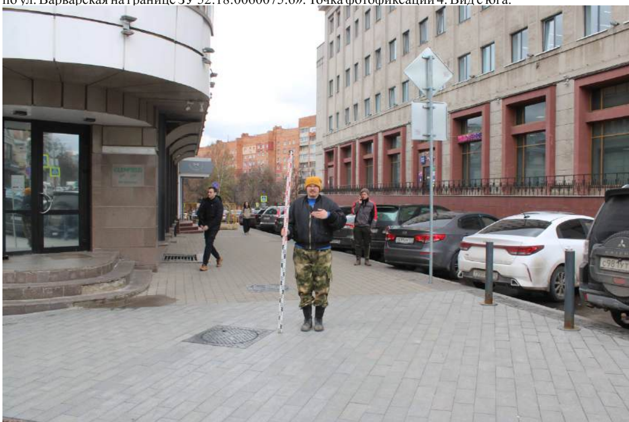
Илл.39. Общий вид земельных участков, отведенных под расположение проектируемого объекта: «Квартальные тепловые сети от НТЦ, 2 очередь (ТК-236-1)», адрес (местоположение): г. Нижний Новгород, Нижегородский район, от ТК-236-1 у д.32 Д по ул. Варварская до т. в 36 м на СЗ от С угла д.32Д по ул. Варварская на границе ЗУ 52:18:0060075:6». Точка фотофиксации 4. Вид с запада.
