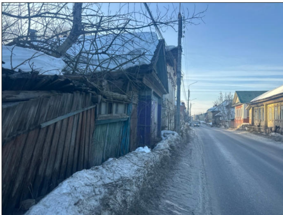
Илл. 16. Видовая фотофиксация трассы проектируемого объекта «Сеть газораспределения низкого давления к жилым домам по улице Пискунова г. Городец Городецкого района Нижегородской области». Точка фотофиксации 1. Вид с ССВ на начальный отрезок трассы проектируемого объекта, проходящий по ул. М. Горького (точку врезки в существующий газопровод, место расположения рабочего котлована)
