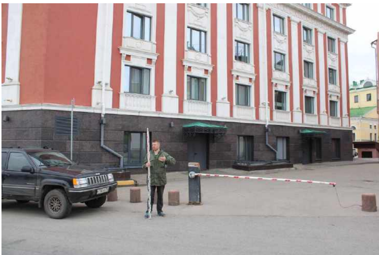
Илл. 60. Общий вид земельных участков, отведенных для размещения объекта: «Капитальный ремонт автомобильной дороги 22-401 ОП МГ 2140 «Ул. Пожарского от пл. Минина до ул. Пискунова» в Нижегородском районе г. Нижнего Новгорода». Точка фотофиксации 5. Вид с запада.
