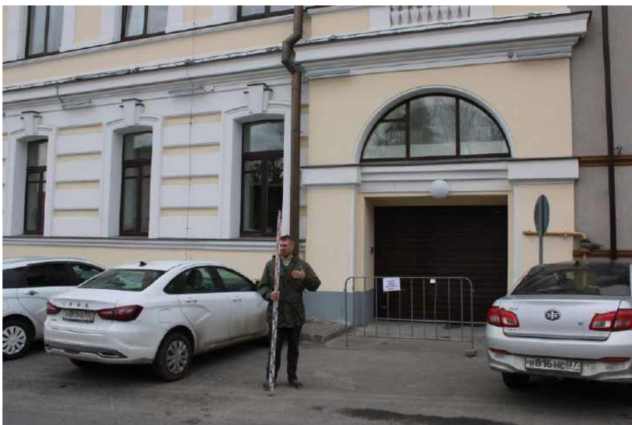
Илл.48. Общий вид земельных участков, отведенных для размещения объекта: «Капитальный ремонт автомобильной дороги 22-401 ОП МГ 2140 «Ул. Пожарского от пл. Минина до ул. Пискунова» в Нижегородском районе г. Нижнего Новгорода». Точка фотофиксации 2. Вид с запада.
