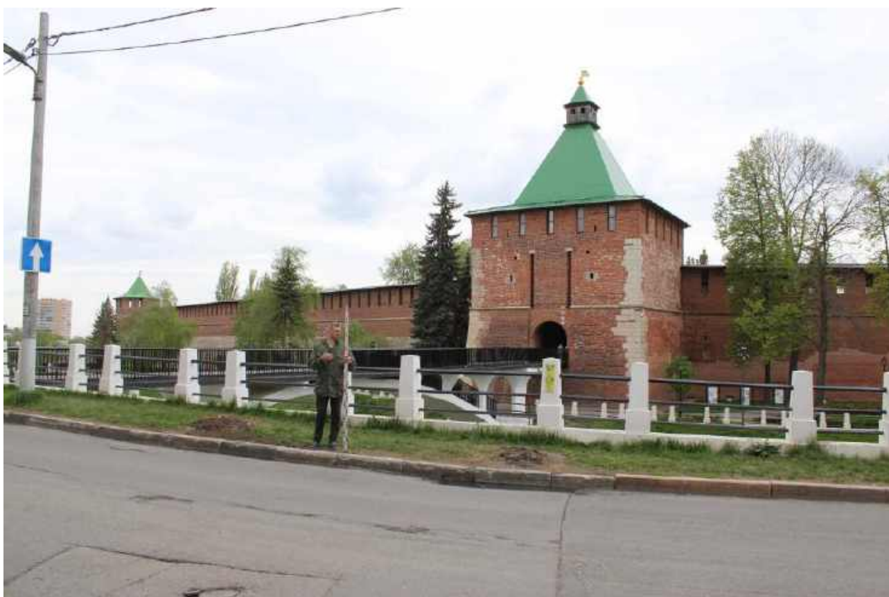
Илл. 58. Общий вид земельных участков, отведенных для размещения объекта: «Капитальный ремонт автомобильной дороги 22-401 ОП МГ 2140 «Ул. Пожарского от пл. Минина до ул. Пискунова» в Нижегородском районе г. Нижнего Новгорода». Точка фотофиксации 4. Вид с востока.
