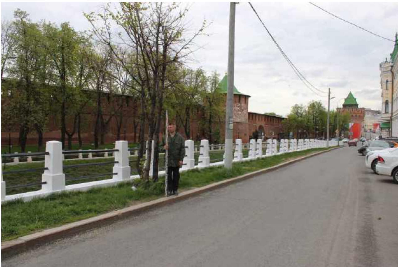
Илл. 51. Общий вид земельных участков, отведенных для расположения объекта: «Капитальный ремонт автомобильной дороги 22-401 ОП МГ 2140 «Ул. Пожарского от пл. Минина до ул. Пискунова» в Нижегородском районе г. Нижнего Новгорода». Точка фотофиксации 3. Вид с юга.
