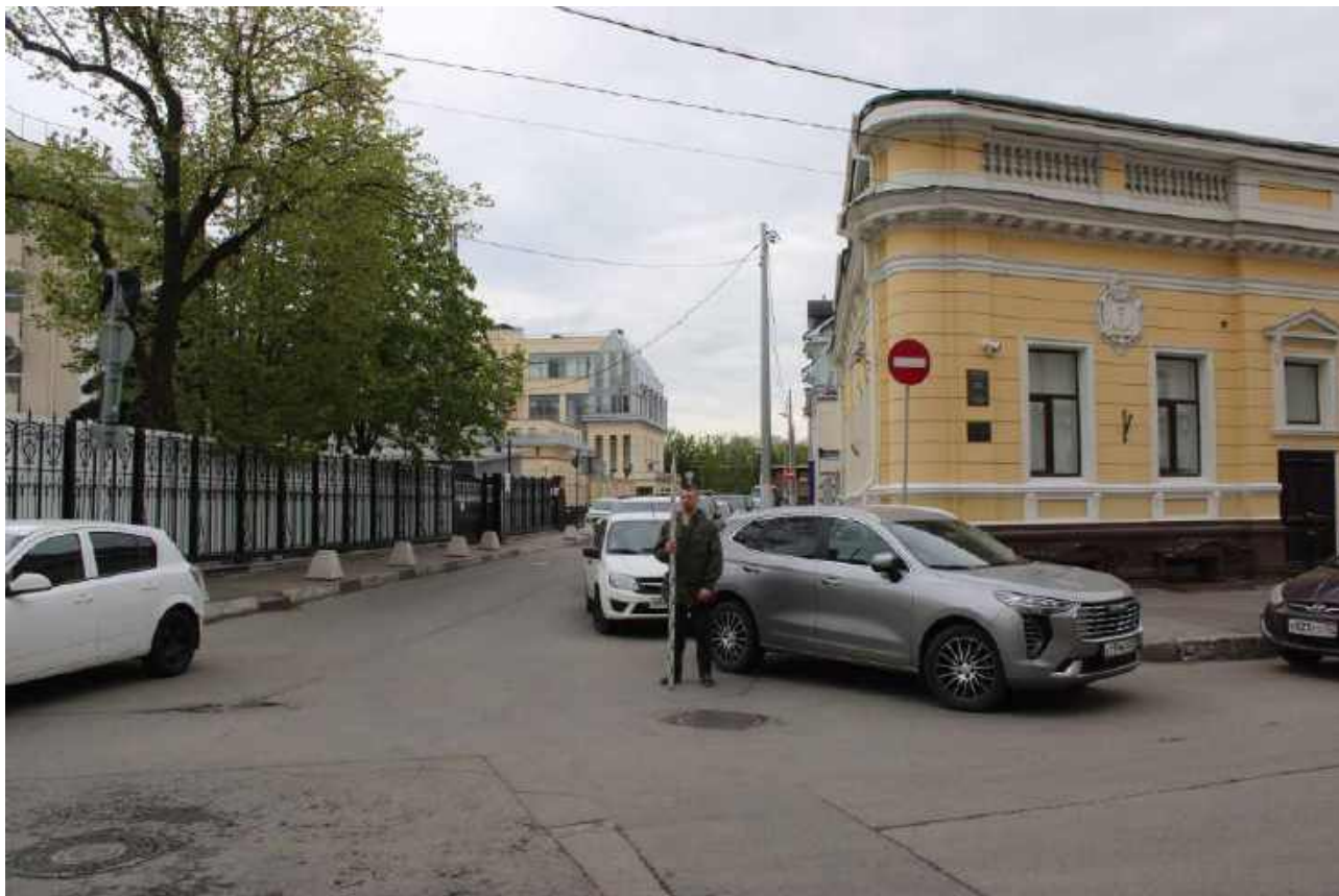
Илл. 71. Общий вид земельных участков, отведенных для расположения объекта: «Капитальный ремонт автомобильной дороги 22-401 ОП МГ 2140 «Ул. Пожарского от пл. Минина до ул. Пискунова» в Нижегородском районе г. Нижнего Новгорода». Точка фотофиксации 6. Вид с юга.
