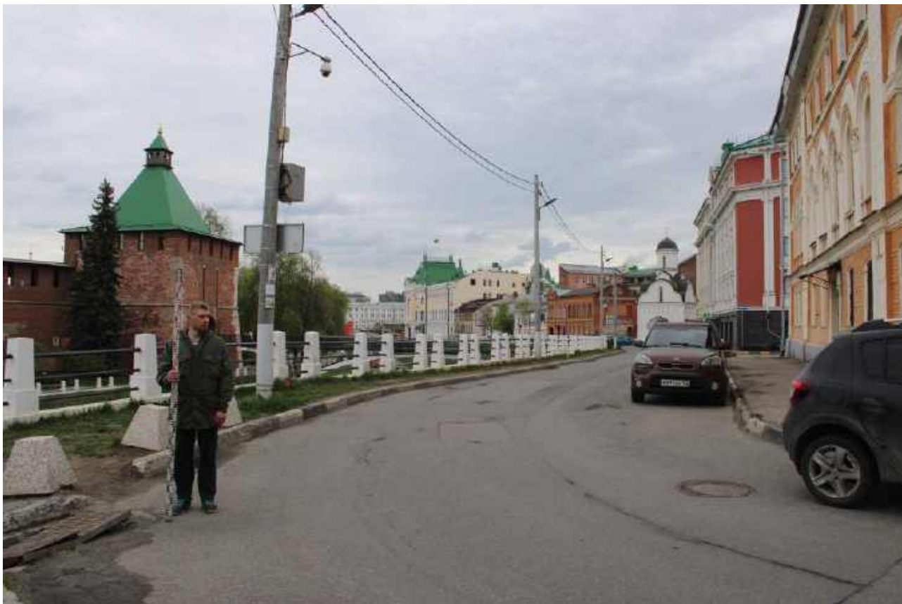
Илл. 63. Общий вид земельных участков, отведенных для расположения объекта: «Капитальный ремонт автомобильной дороги 22-401 ОП МГ 2140 «Ул. Пожарского от пл. Минина до ул. Пискунова» в Нижегородском районе г. Нижнего Новгорода». Точка фотофиксации 6. Вид с юга.
