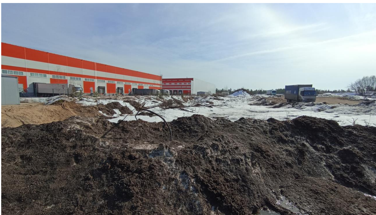
Ил.14. Нижегородская обл., г.о.г. Дзержинск, восточный промрайон Оргстекло, участок с к.н 52:21:0000012:2543. Восточная окраина, засыпанный котлован. Точка фотофиксации 5.
