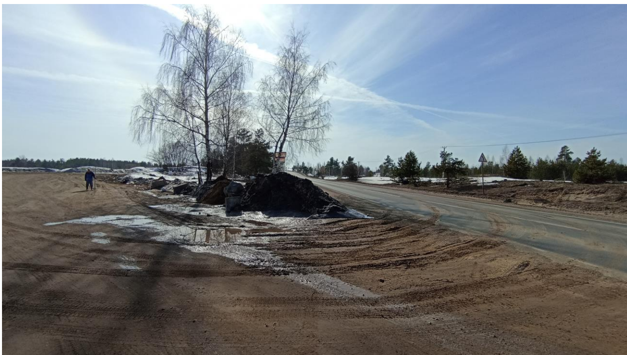
Ил.15. Нижегородская обл., г.о.г. Дзержинск, восточный промрайон Оргстекло, участок с к.н 52:21:0000012:2543. Участок обследования. Вид с северо-востока. Точка фотофиксации 6.
