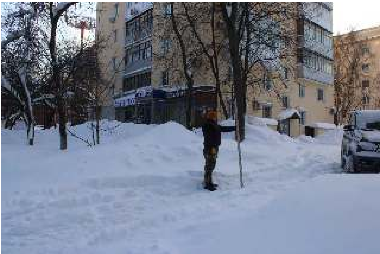
Илл. 24. Общий вид земельных участков, отведенных для расположения объекта: «Теплотрасса отопления от ТК-224 у д. 1 по ул. Ванеева до ТК-224-2 у д. 104 к5 по ул. Белинского». Точка фотофиксации 2. Вид с севера.
