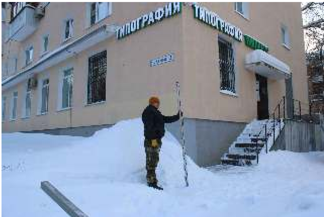
Илл. 28. Общий вид земельных участков, отведенных для расположения объекта: «Теплотрасса отопления от ТК-224 у д. 1 по ул. Ванеева до ТК-224-2 у д. 104 к5 по ул. Белинского». Точка фотофиксации 3. Вид с севера.
