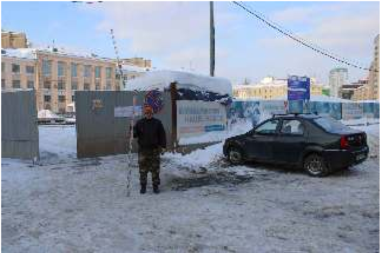
Илл. 30. Общий вид земельных участков, отведенных для размещения объекта: «Теплотрасса отопления от ТК-224 у д. 1 по ул. Ванеева до ТК-224-2 у д. 104 к5 по ул. Белинского». Точка фотофиксации 4. Вид с юга.
