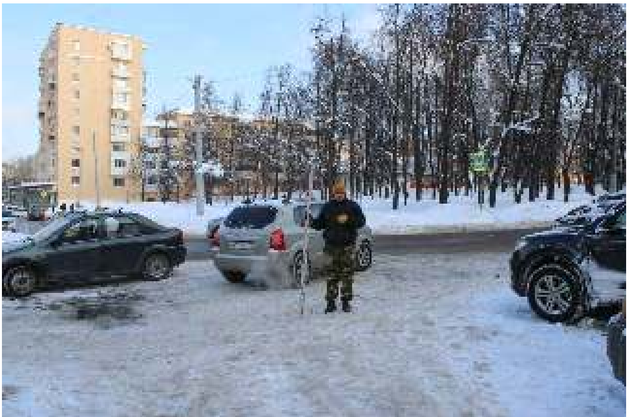
Илл. 31. Общий вид земельных участков, отведенных для размещения объекта: «Теплотрасса отопления от ТК-224 у д. 1 по ул. Ванеева до ТК-224-2 у д. 104 к5 по ул. Белинского». Точка фотофиксации 4. Вид с запада.
