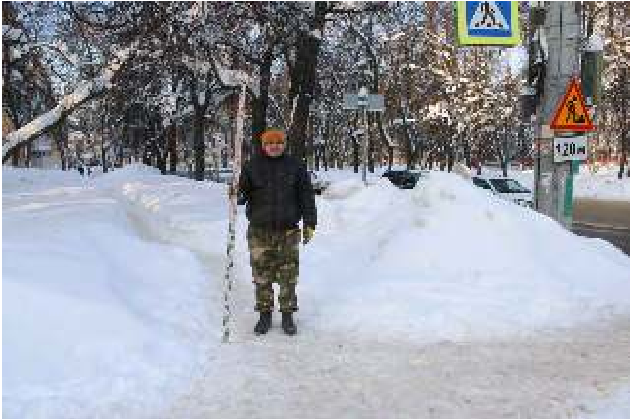
Илл. 18. Общий вид земельных участков, отведенных для расположения объекта: «Теплотрасса отопления от ТК-224 у д. 1 по ул. Ванеева до ТК-224-2 у д. 104 к5 по ул. Белинского». Точка фотофиксации 1. Вид с юга.
