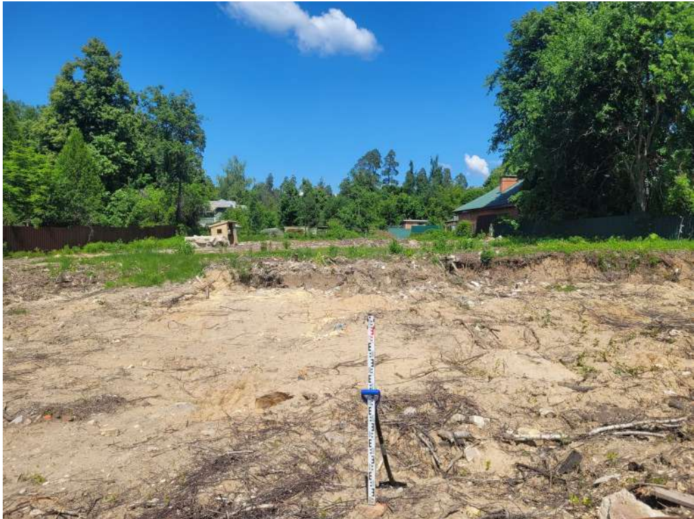
Илл. 12. Точка фотофиксации 2. Вид с ЮЗ.
