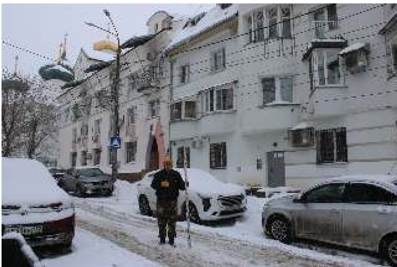
Илл.23. Общий вид земельных участков, отведенных для расположения объекта: Теплотрасса отопления от вывода из д. 17 по пер. Плотничный до точки в 12 м. от ТК-15а уд. 17 по пер. Плотничный в сторону УТ-15б у д.17 по пер. Плотничный. Точка фотофиксации 1. Вид с запада.
