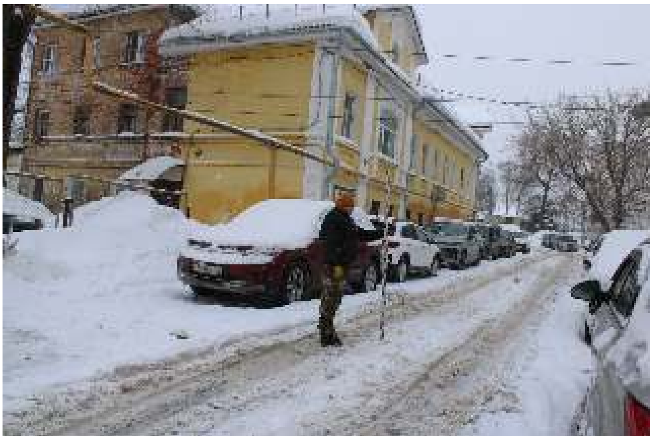
Илл. 22. Общий вид земельных участков, отведенных для расположения объекта: Теплотрасса отопления от вывода из д. 17 по пер. Плотничный до точки в 12 м. от ТК-15а уд. 17 по пер. Плотничный в сторону УТ-15б у д.17 по пер. Плотничный. Точка фотофиксации 1. Вид с севера.
